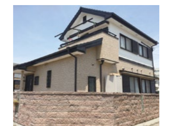
WBアート施工実績
